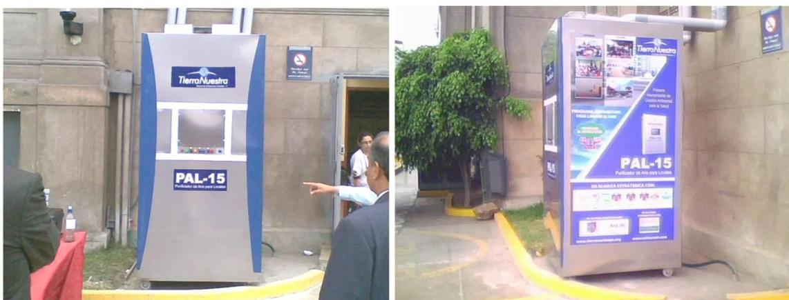
**INYECTA 1,500 m<sup>3</sup>/h AIRE PURIFICADO A SALA DE EMERGENCIA**
